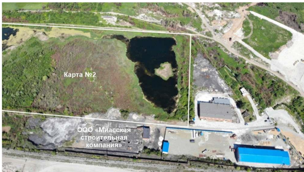
Рисунок 1.4 - Вид участка работ из точки ф.2 (Граф.прил 1) на северо-запад.
