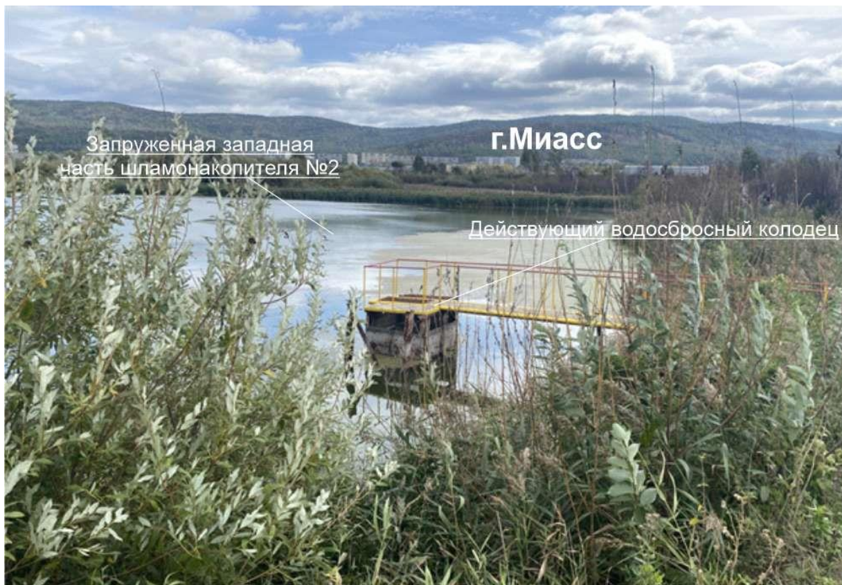
Рисунок 1.10 - Водосбросной колодец золошламонакопителя № 2(восточная карта) шламонакопителя
