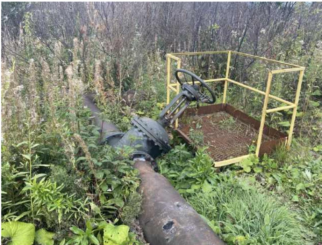
Рис. 1.12 - Отсечная задвижка на сбросном трубопроводе осветленной воды в р.Миасс с площадкой обслуживания
