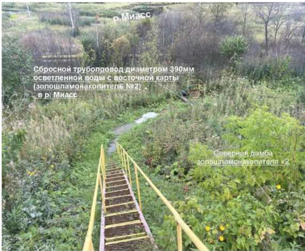
Рис.1.11 - Вид участка сбросного трубопровода  $\varnothing 390$ мм. осветленной воды с восточной карты шламонакопителя (золошламонакопитель №2) в р. Миасс с лестничным переходом через дамбу и площадкой обслуживания отсечной задвижки на трубопроводе
